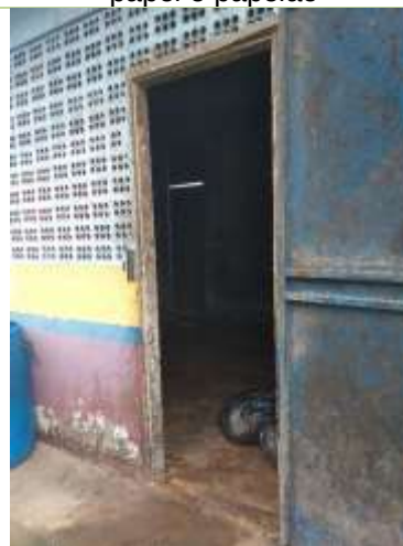
Figura 12 - Abrigo externo de resíduos do hospital municipal
