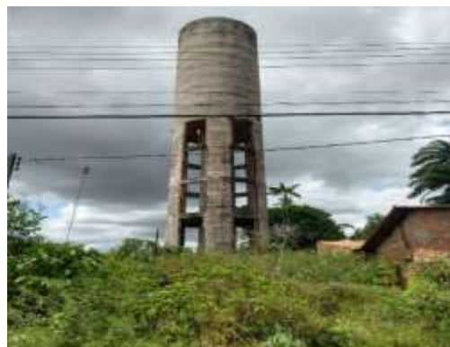
Figura I – Reservatório Suspenso da Alameda das Samambaias.
