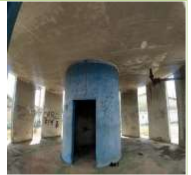
Figura III – Porta de acesso ao interior do Reservatório Suspenso
