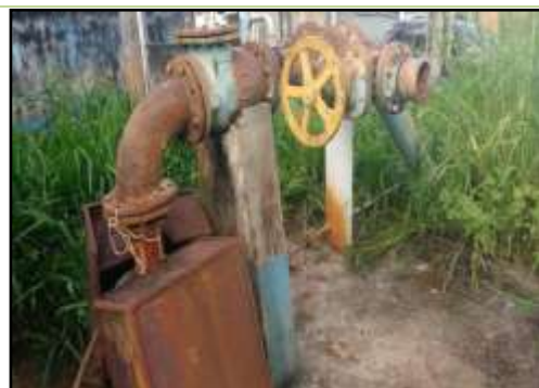
Figura IV – Bomba de Sucção
