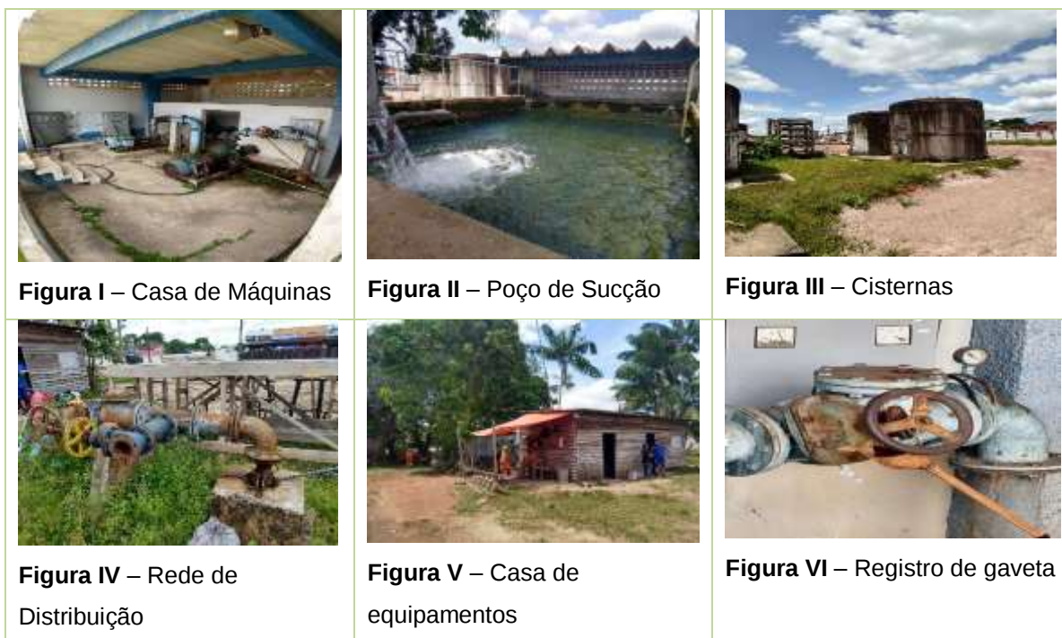
Quadro 12 - Sistema e Abastecimento de água do Centro.
