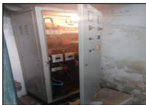
Figura II – Caixa de Passagem
