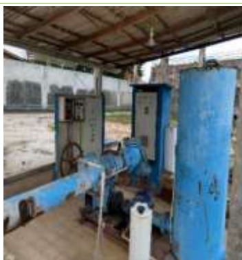
Figura II – Casa de Máquinas
