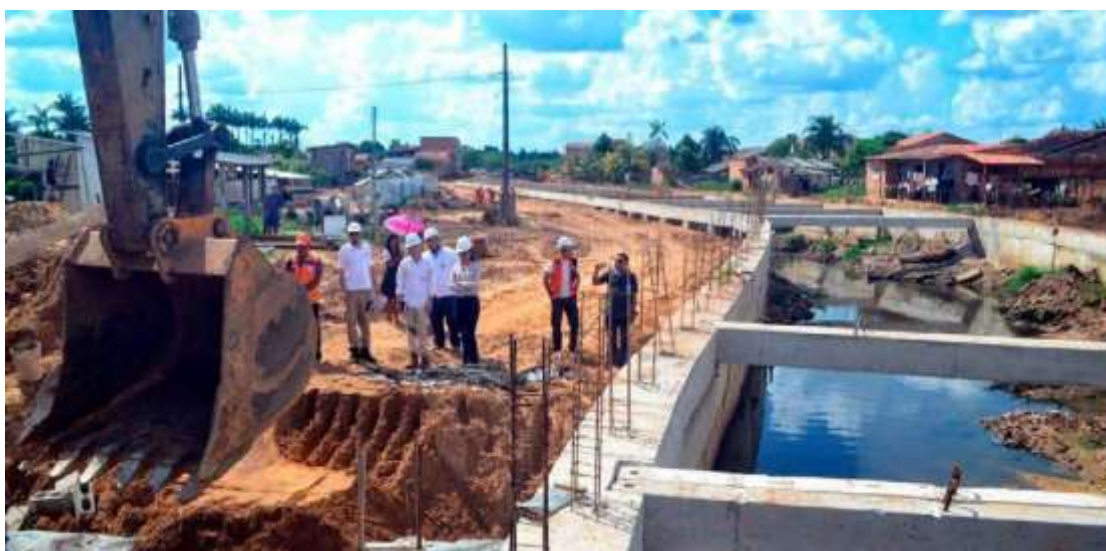
Figura 44 - Processo de Construção do canal do Salgado Grande.
