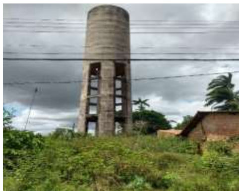
Figura I – Reservatório Suspenso da Alameda das Samambaias.
