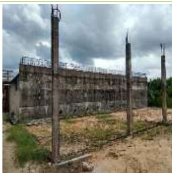
Figura V – Estrutura não finalizada
