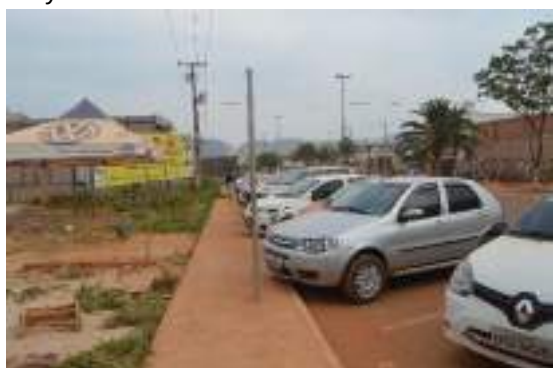
Foto 9-G: Calçada estreita (1,40 m) – Av. Weyne Cavalcante
