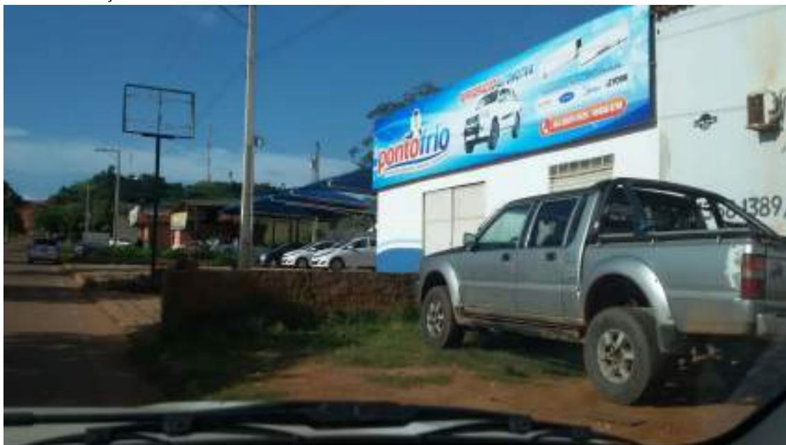
Foto 35: Calçada inacessível com obstáculos
