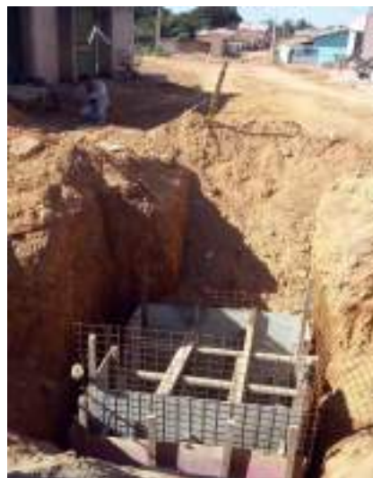
Foto 92 B: Rua Minas Gerais
