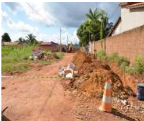
Foto 89 A: Rua São Francisco
