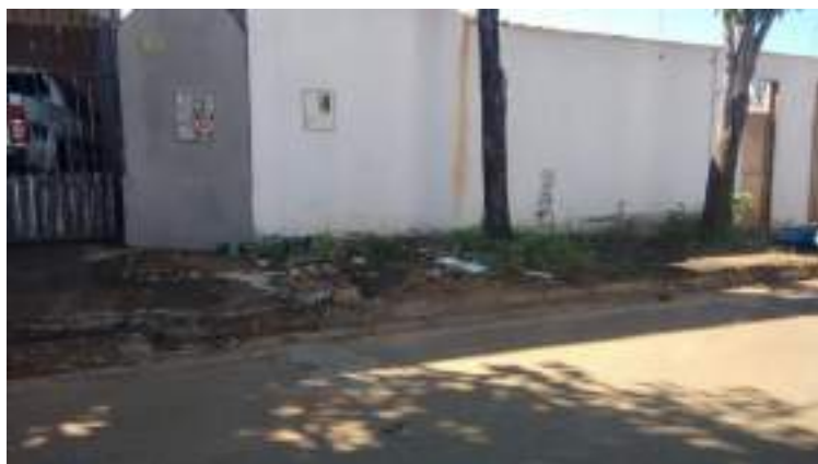
Foto 28: Árvores com raízes protuberantes em calçada no bairro Jardim das Palmeiras
