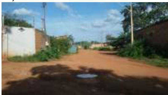
Foto 9: Problemas na infraestrutura das calçadas Foto 9-A: Ausência de delimitação de calçada – Bairro Nova Jerusalém
