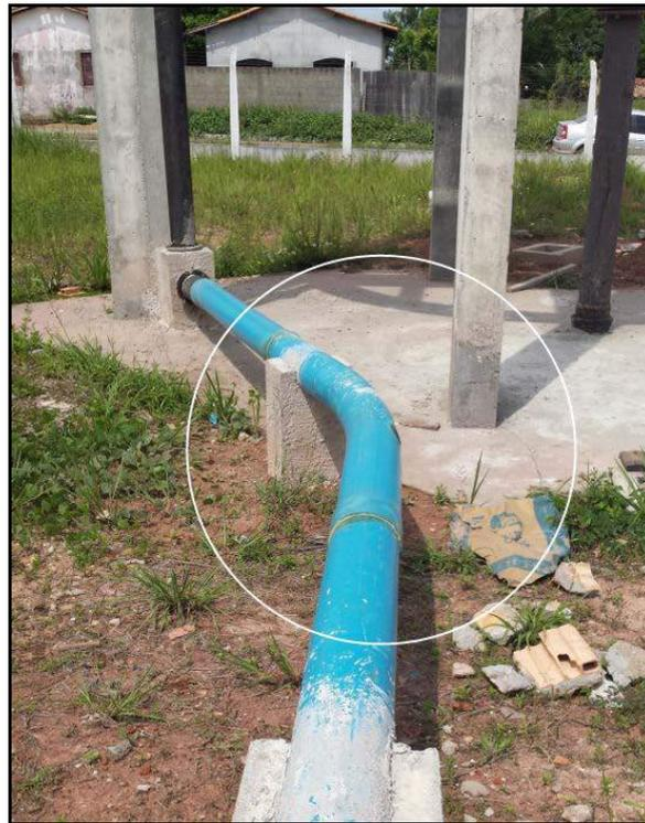
Figura 17 - Barrilete de Recalque para Reservatório Elevado.
