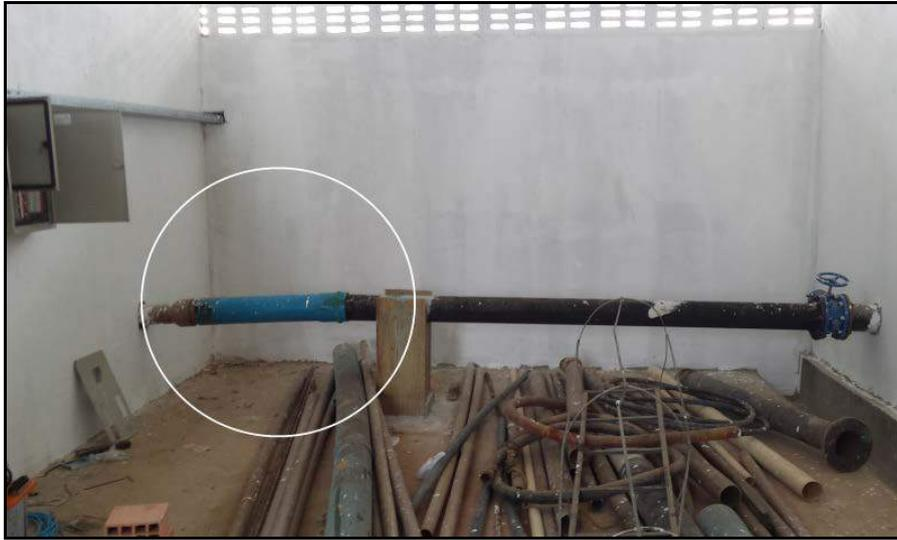
Figura 18 - Barrilete de Recalque para Reservatório Apoiado.
