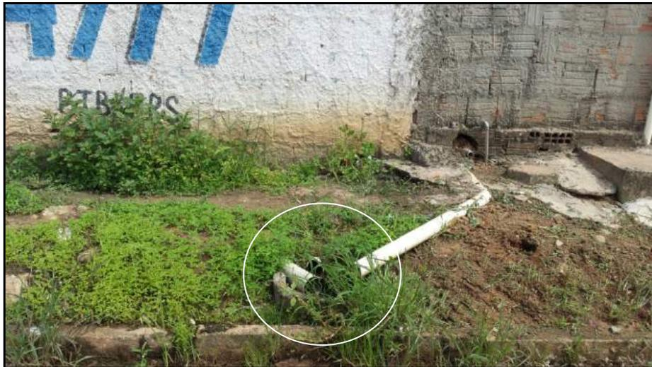
Figura 36 - Sistema de Drenagem Centro - Lançamento de Água Residual em Galeria de Águas Pluviais.
