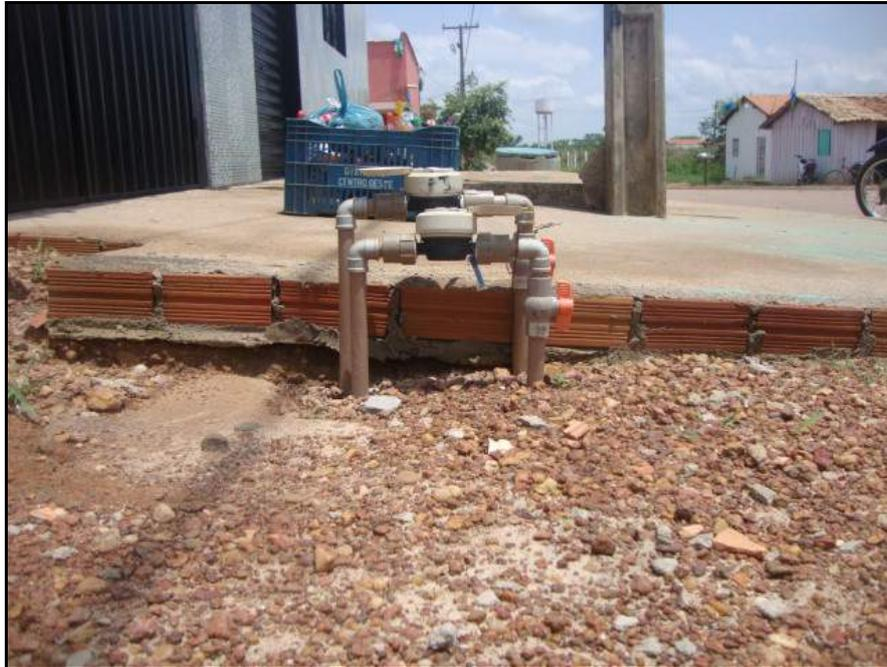
Figura 21 - Hidrômetros instalados.
